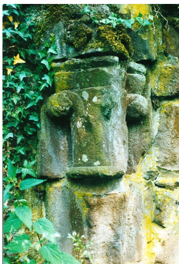
Recyclage van afbraakmateriaal van de abdij van Vrouwenpark in de "gotische" boogbrug bij het aalmoezeniershuis (Paesmans, Greta, 20-03-2014, ©Vlaamse Gemeenschap)
