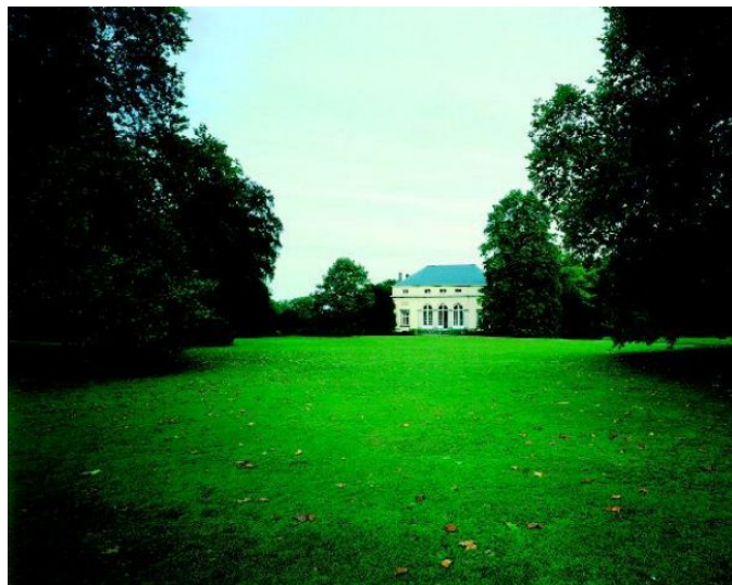
De door Henry ontworpen, nadien verbouwde oranjerie bij het kasteel van Wespelaar (Vandevorst, Kris, 01-01-2003, ©Vlaamse Gemeenschap)
