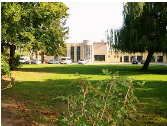
Het huidige 'Sporthotel', oorspronkelijk het administratieve gebouw annex jeugdherberg uit 1948-1949), ontworpen door Frans Van Cleven (Deneef, Roger, 16-10-2006, ©Vlaamse Gemeenschap)
