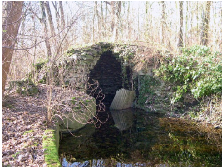
De grot met de aanlegsteiger aan de andere zijde van in 1975 gebouwde viaduct van de Grote Ring (Deneef, Roger, 16-01-2005, ©Vlaamse Gemeenschap)
